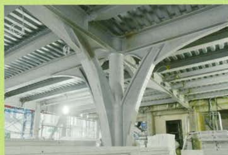
写真2 完成時(鉄骨・道央建鉄株式会社)
